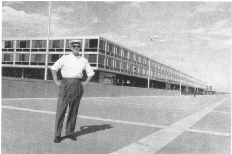
T. T. ved en av bygningene på USA Air Force Academy i Colorado.
