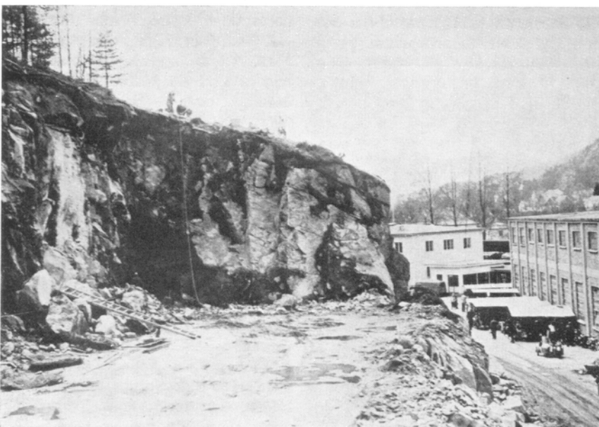
En salve på 600 m er ferdig boret. Den har 120 borhull på tilsammen 750 bormeter.
