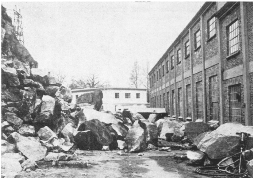
Fjellet etter at 190 kg geomitt har fått virke. Bare en av blokkene nådde helt inn til veggen, og den laget et lite sår i muren.
