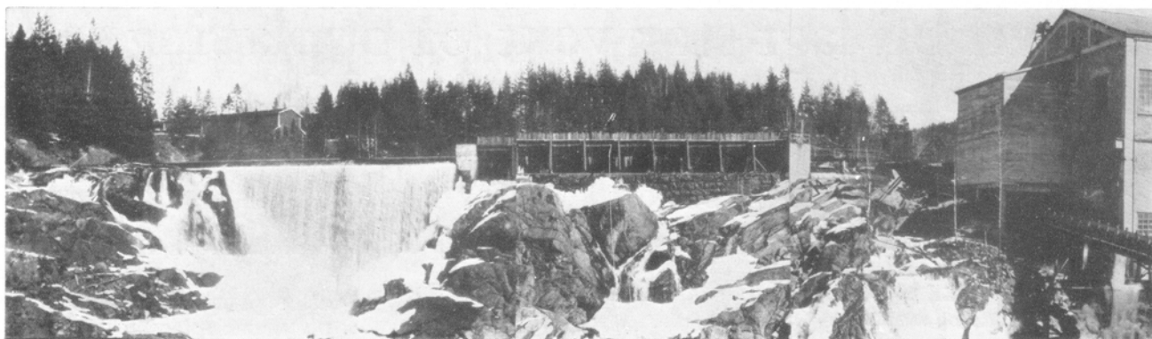
Slik så det ut før der den nye kraftstasjonen nå ligger.
