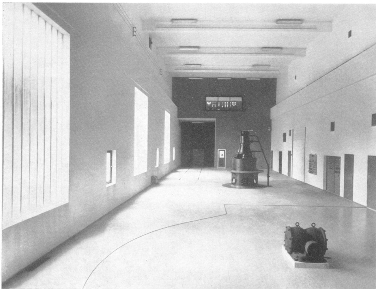
Maskinsalen. — I forgrunnen sees en generator laget i 1890. — Denne har vært i bruk på Kalvild inntil for få år siden.
