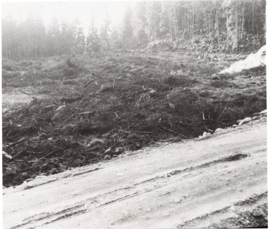
Fyllingen tar til fra høyre.
