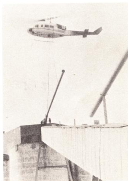
"Montøren" i arbeid.
