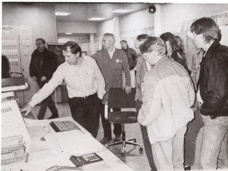
Kontrollrommet i Kokeriet.
