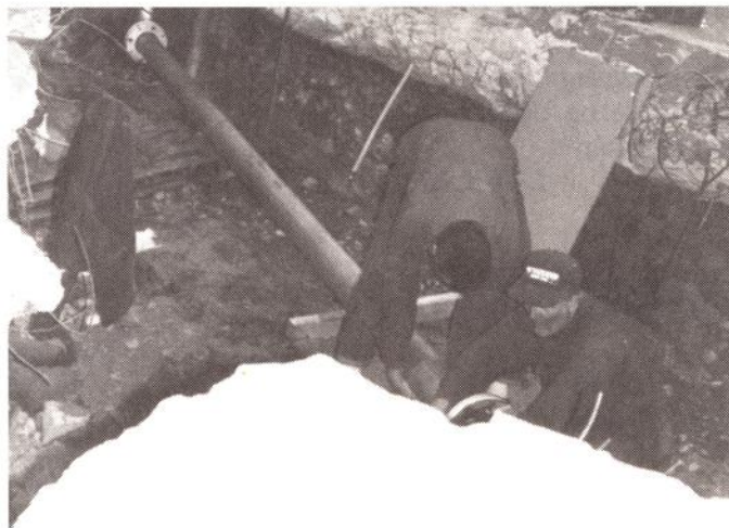
v: Odd Sørensen og Tore Lunden kobler til det nye sprinkleranlegget til Herdeavdelingen på N.W.
